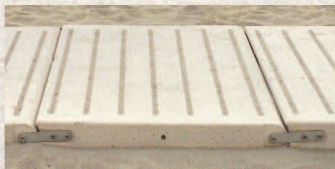
ejemplo de anclaje entre tramos
